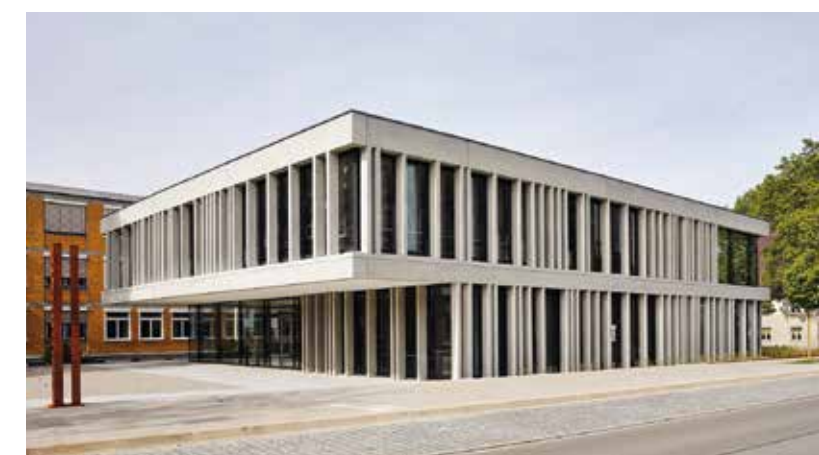
Burkhard Grob Technikerschule in Mindelheim
